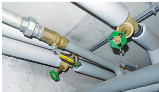
Beim Austausch einzelner Armaturen bleibt der Bestandsschutz für die Gasinstallation bestehen.
