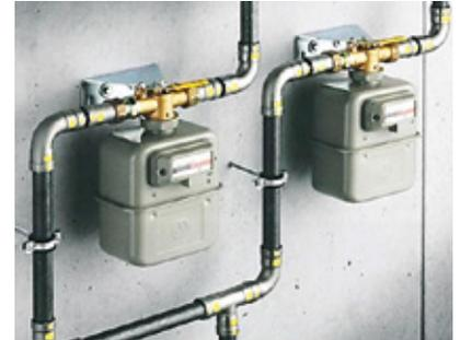
Bei der Erneuerung der Gasinstallationsleitung mit mehr als drei Fittings sind die Forderungen der aktuellen DVGW-TRGI umzusetzen.
